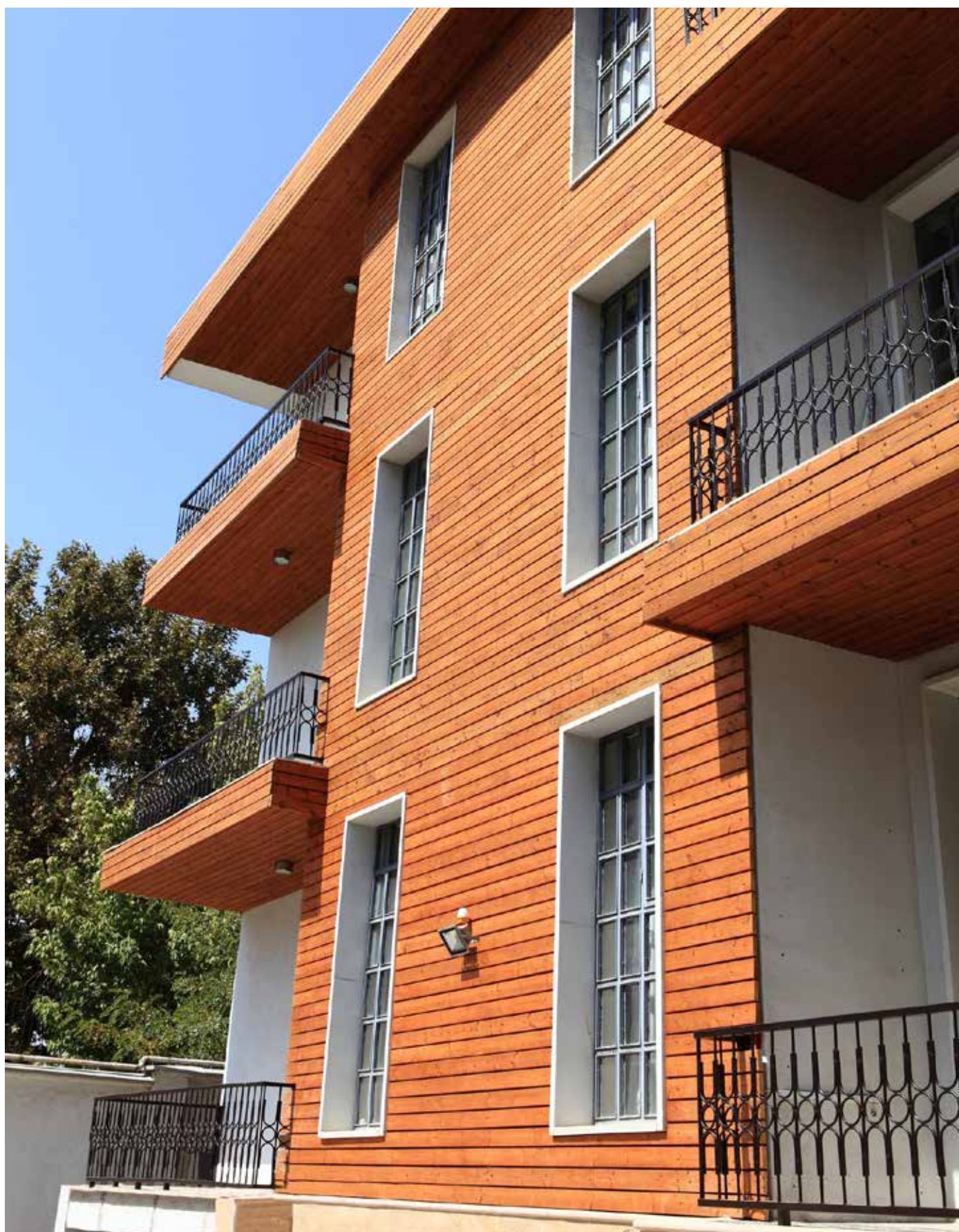
Fasáda REAL FACADE, Thermo borovice, profil Raute 26 x 92 mm, ponecháno přírodní
