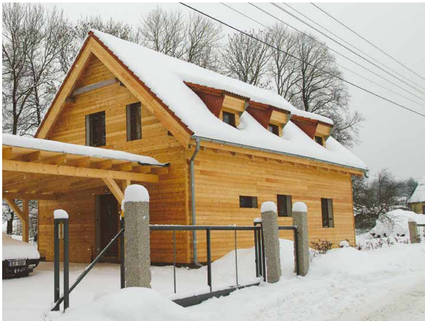
Fasáda REAL FACADE, Slezský modřín, profil Klasika 19 x 146 mm, ponecháno přírodní
