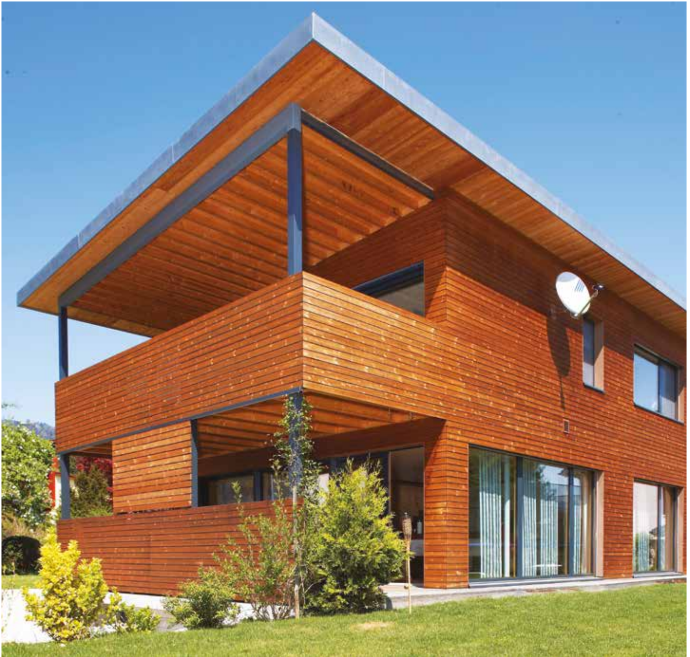
Fasáda REAL FACADE, Thermo borovice profil Raute 26 x 92 mm, ponecháno přírodní
