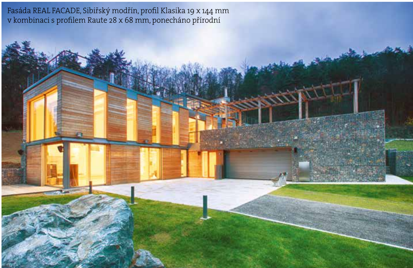
Fasáda, Sibiřský modřín, hoblovaná prkna 20 x 95 mm, povrchová úprava OSMO UV- Ochranný olej Extra č. 420 bezbarvý
