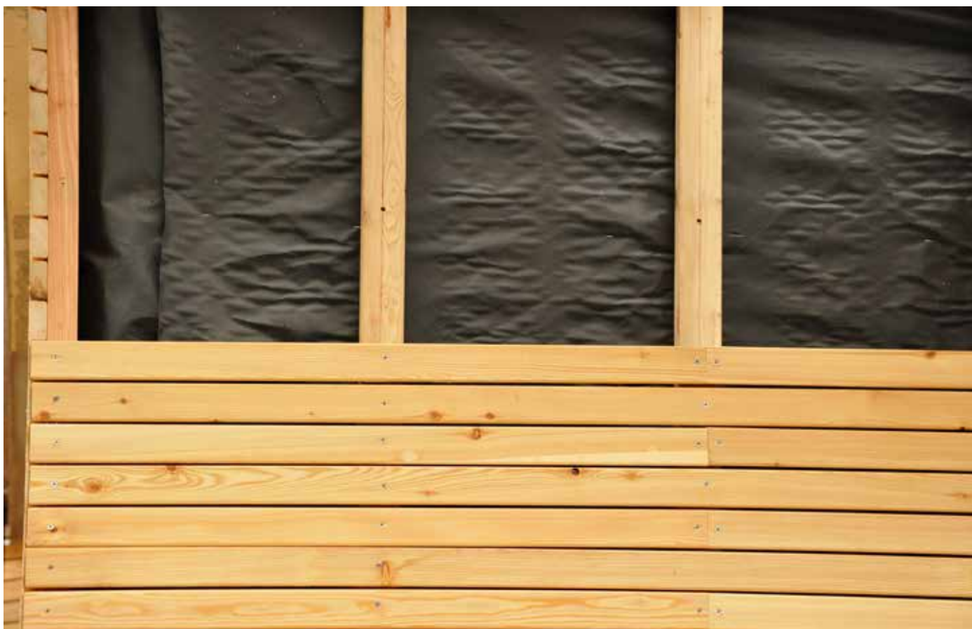
Pokládka profilu Raute 28 x 68 mm, odvětrávaná fasáda s použitím difúzní fasádní fólie
