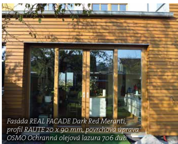
Fasáda REAL FACADE Dark Red Meranti, profil RAUTE 20 x 90 mm, povrchová úprava OSMO Terasový olej Bangkirai č. 006
