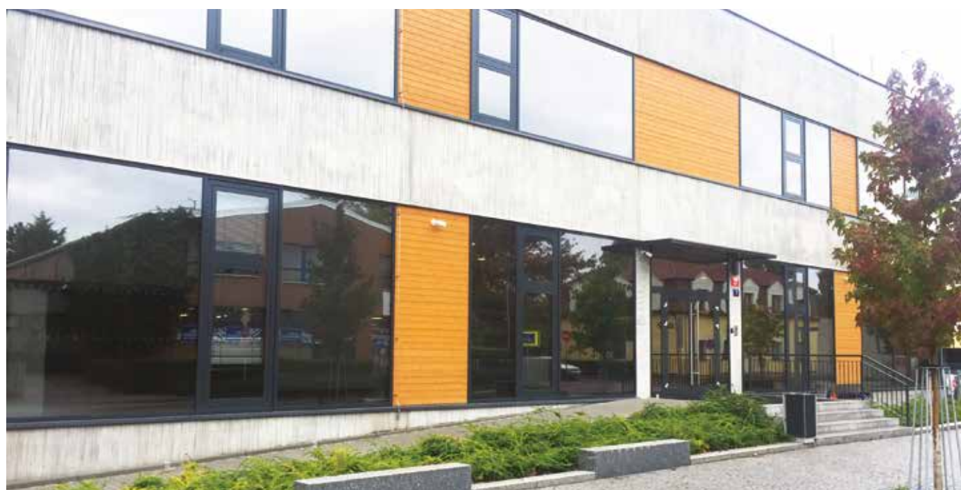
Fasáda REAL FACADE, Severský smrk, profil klasika 19 x 146 mm, povrchová úprava OSMO – Ochranná olejová lazura č. 702 Modřín
